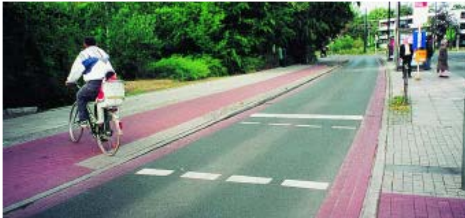
Φωτ. 3.4. Βρετανία. Γερμανία. Ποδηλατόδρομος στο πεζοδρόμιο επιστρωμένος με κόκκινους κυβόλιθους. Ο ποδηλατόδρομος οριοθετείται με δύο λωρίδες, πλάτους περίπου 0,5 μ., που αποτελούνται από κυβόλιθους από πέτρα. Στη συνέχεια, από τη μια πλευρά ακολουθεί η πλακόστρωση του πεζοδρομίου και από την άλλη το κράσπεδο. Σημειώνεται ότι το οδόστρωμα που είναι μιας μόνο λωρίδας από άσφαλτο, οριοθετείται και στις δύο του πλευρές, στη θέση των ρειθρών, από τρεις σειρές κόκκινων κυβόλιθων. Η υπόλοιπη διατομή του δρόμου διατίθεται στο τραμ και στη νησίδα όπου διαμορφώνεται η στάση.
