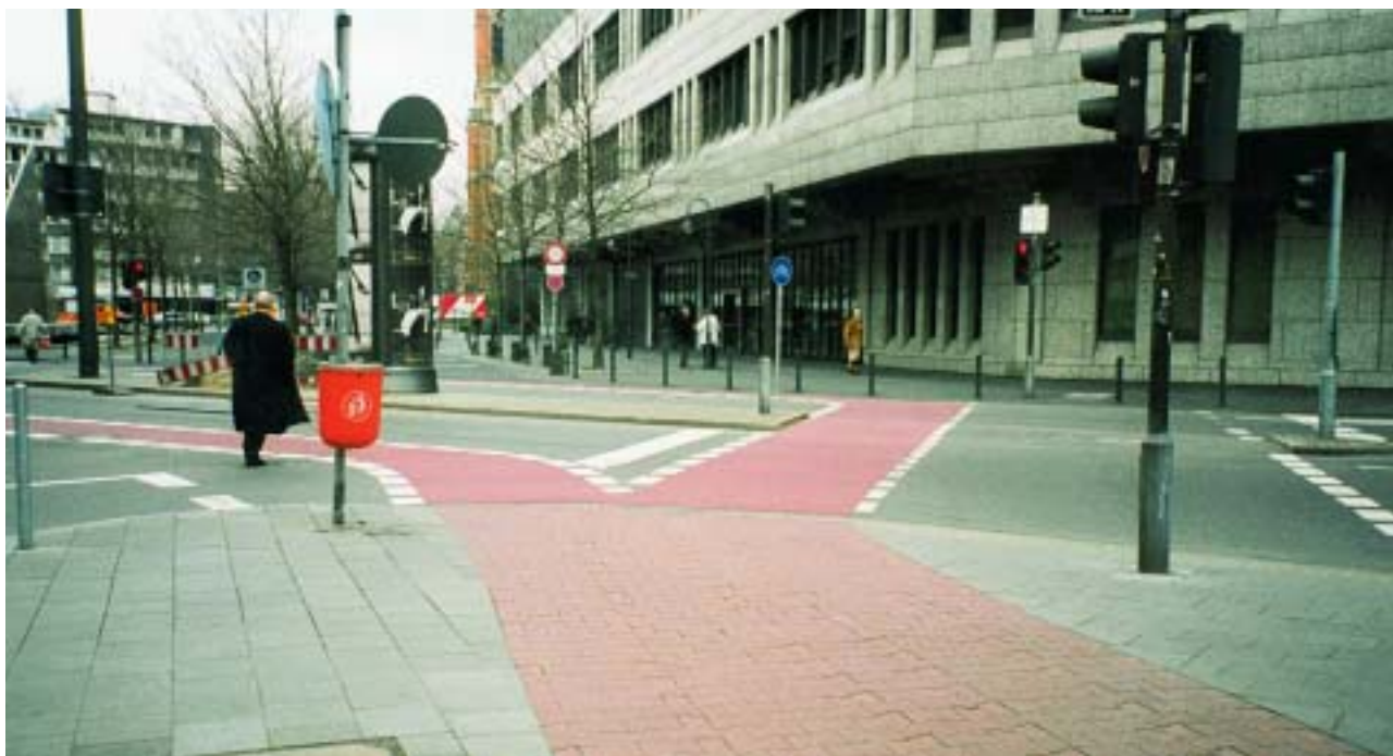
Φωτ. 3.3. Dusseldorf. Γερμανία. Παράδειγμα από αστική περιοχή. Κόκκινοι κυβόλιθοι για τη σήμανση λωρίδας ποδηλάτου σε πλακοστρωμένο πεζοδρόμιο. Η προέκταση της λωρίδας στο οδόστρωμα σημαίνεται με κόκκινο θερμοπλαστικό υλικό. Ωστόσο, δεν μπορεί να θεωρηθεί ιδιαίτερα επιτυχής η σχέση μεταξύ των δύο αποχρώσεων κόκκινου. Η σύνδεση μεταξύ των λωρίδων ποδηλάτου, του πεζοδρομίου και του οδοστρώματος, στην περίπτωση αυτή, δεν αισθητικά πειστική.
